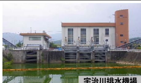
宇治川排水機場
