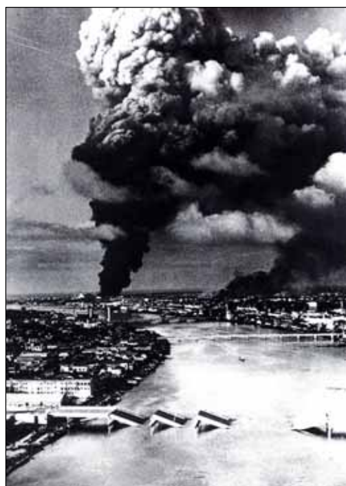
写真5-3 地震で発火した昭和石油新潟製油所と信濃川に落ちた昭和大橋
