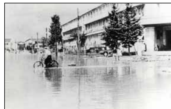
写真 4-10 柿川流域の浸水状況 (旧日赤病院前)
