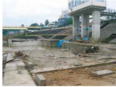
小千谷市千谷川 低水護岸破
