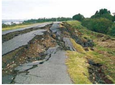
長岡市三俣野 大規模崩壊、天端亀裂
