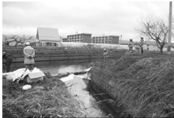
写真 11-18 オイルフェンス・吸着マットによる油除去作業（須坂市）
