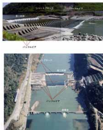
写真 4-65 バツフルピアの設置状況
