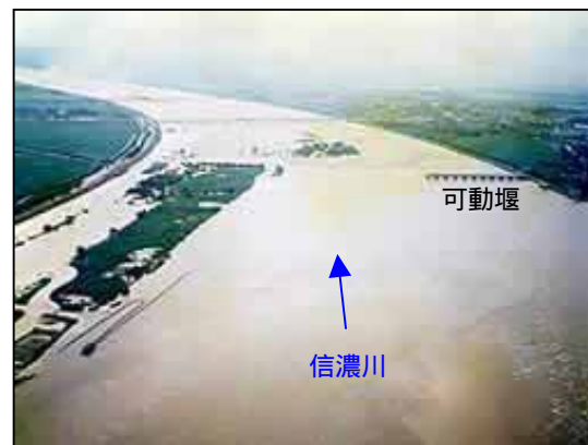
写真 4-38 大河津可動堰付近の様子
