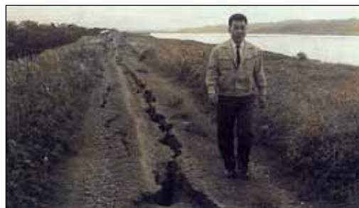
写真5-11 真野代地先の堤防亀裂
