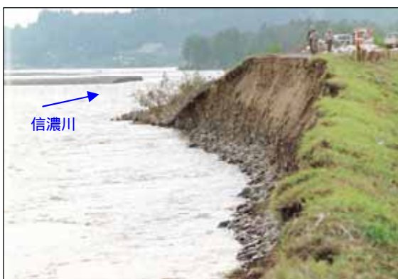
写真 4-33 十日町高島地先での堤防欠壊状況
