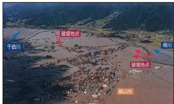
写真 4-32 樽川の破堤状況
