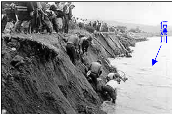
写真 4-15 長岡水梨地区の堤防欠壊状況
