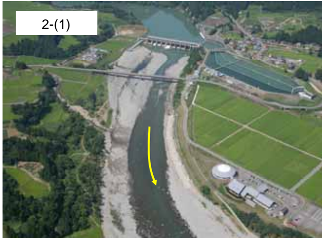
JR 宮中取水ダム付近【H18 撮影】
