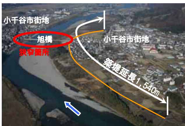
写真 4-82 東小千谷地区事業箇所垂直写真
