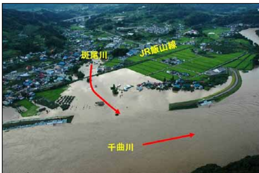
写真 4-48 中野市替佐地区(堤防整備中)の浸水状況
