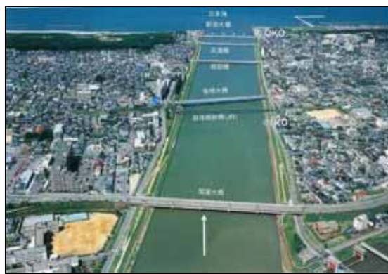
写真 4-85 関屋分水路(現在)
