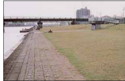
写真5-9 やすらぎ堤整備後
