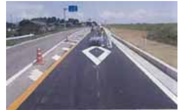
写真 5-21 町軽井堤防復旧工事
