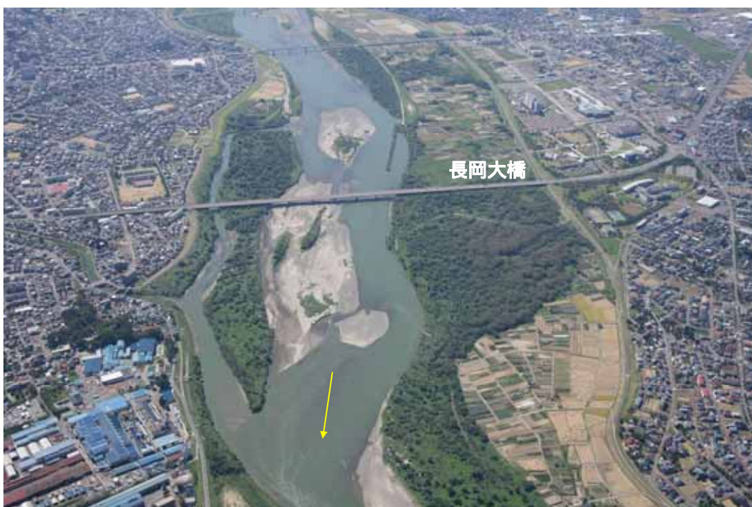
写真 11-11 信濃川中流 15km（長岡大橋）付近の樹木群繁茂状況
