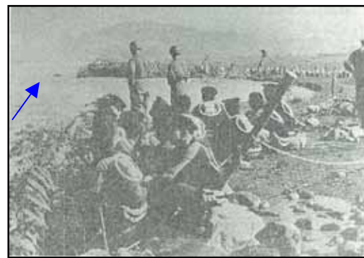
写真 4-14 犀川右岸明科地区付近の水防作業
