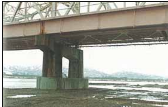
写真 4-74 長生橋橋脚補強工事
