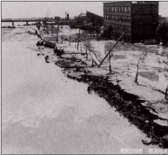
写真5-7 地震と津波により流出した堤防
