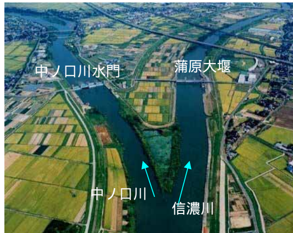
写真 4-88 蒲原大堰と中ノ口川水門
