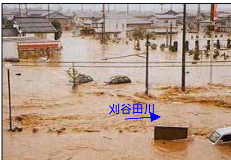
写真 4-43 刈谷田川の破堤状況(旧中之島町)
