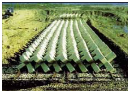
写真 4-70 導流堤設置状況 幅 20m の粗朶沈床の上に 2t の異形ブロックを幅 12m で三層積み
