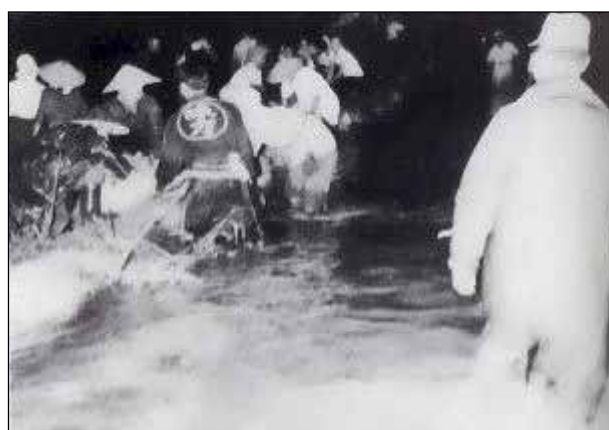
写真 4-17 水防作業の様子
