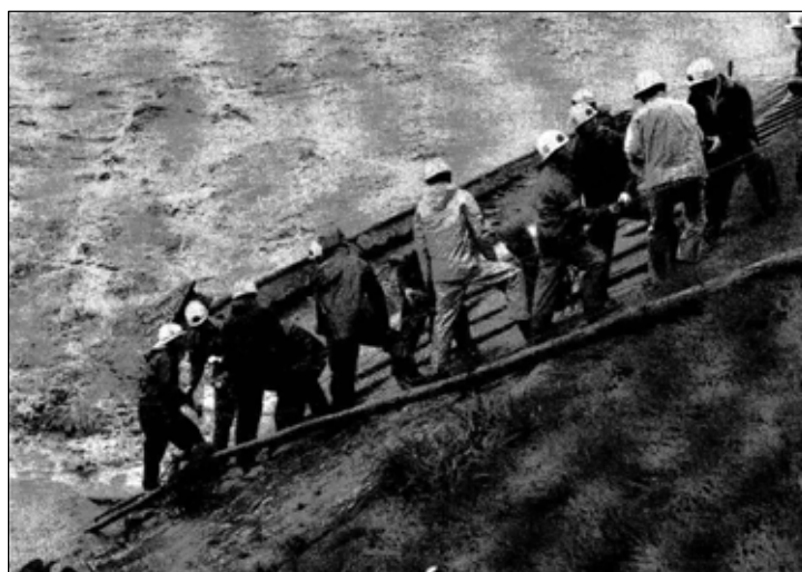
写真 4-29 上田市大屋地先の流失箇所の水防の様子
