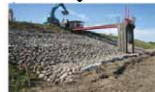
写真 5-22 町軽井堤防復旧工事
