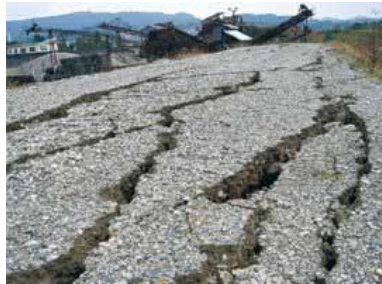
小千谷市川井 無数の縦断亀裂
