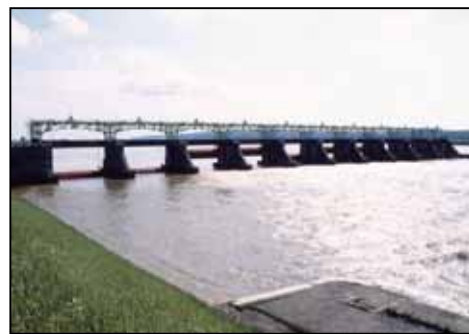
写真 4-64 大河津分水路可動堰 現在の様子 (出典：信濃川河川事務所資料)
