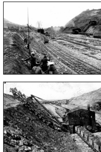
写真 4-61 大河津分水路開削工事実施状況
