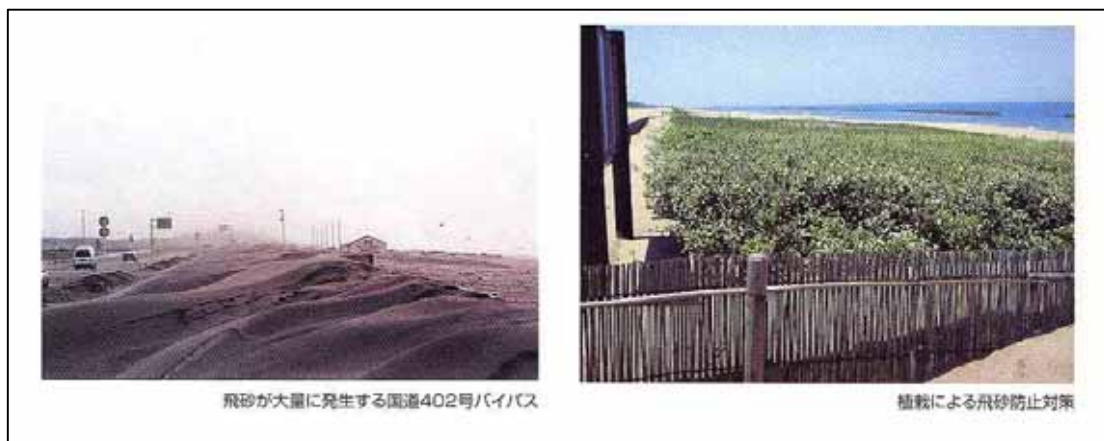
写真 4-93 新潟海岸における海岸保全事業（関屋分水路左岸）
