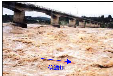
写真 4-40 十日町橋の状況
