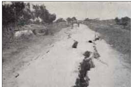
写真5-10 横田地先の堤防亀裂
