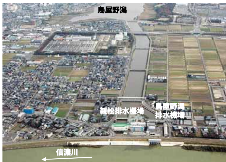
写真 11-7 鳥屋野潟排水機場
