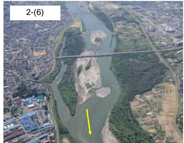
信濃川長岡大橋付近【H18 撮影】
