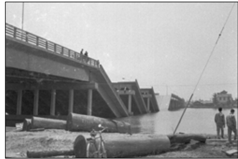
写真5-4 地震により落下した昭和大橋
