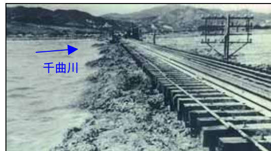
写真 4-11 信越線篠ノ井鉄橋での出水状況
