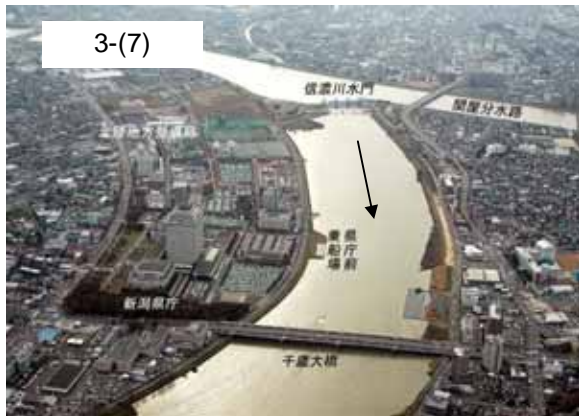
本川下流（やすらぎ堤付近）
