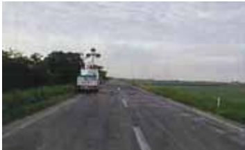
写真 5-20 野中才(下流)堤防復旧工事
