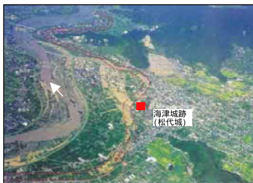
写真 4-50 瀬直しによる河道の変化
