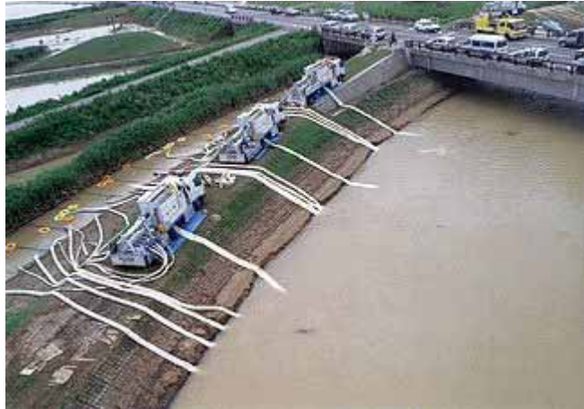
写真 11-6 排水ポンプ車による排水の状況
