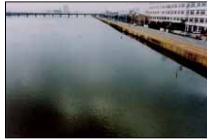
写真5-8 災害復旧後の堤防
