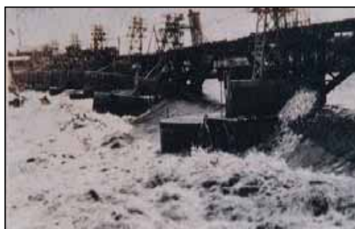
写真 4-63 陥没した自在堰 (出典：信濃川河川事務所資料)
