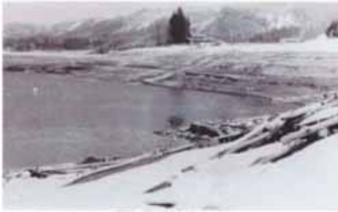
出典：国土交通省 減水状況（20m 低下、昭和 43 年 4 月）
