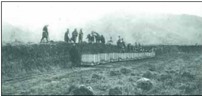
写真 4-52 飯山改修工事(大正 13 年)
