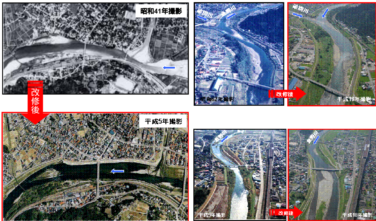
図 4-53 改修前後の様子
