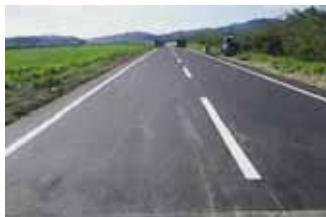
写真 5-19 野中才(上流)堤防復旧工事
