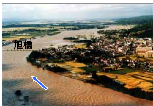
写真 4-81 昭和 57 年 9 月洪水時の状況
