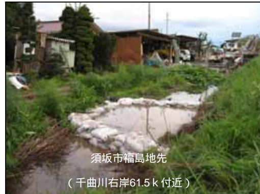
平成18年7月洪水堤防漏水状況
