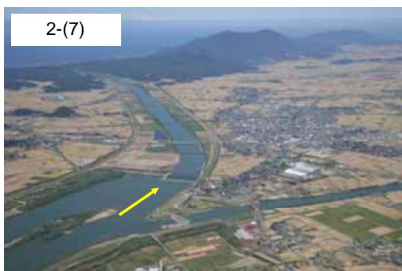
大河津分水路分派点より下流を望む【H18 撮影】
