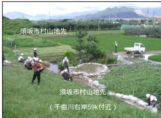
平成18年7月洪水堤防漏水状況
