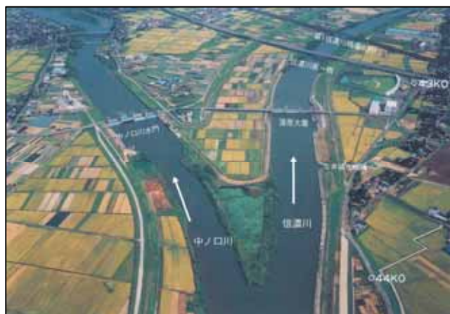
写真 11-5 蒲原大堰、中ノ口川水門
