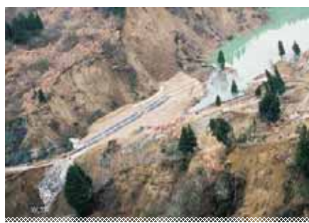
写真5-14 山古志村寺野地区における直轄事業による仮排水路設置状況
