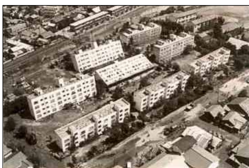
写真5-1 液状化により傾いた県営アパート
