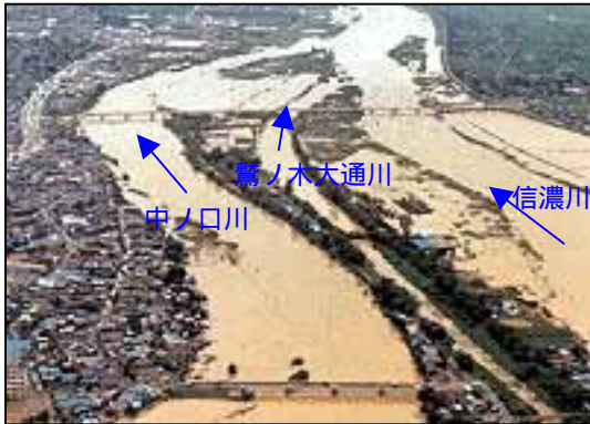
写真 4-21 信濃川・中ノ口川・鷲ノ木大通川 合流点の様子
