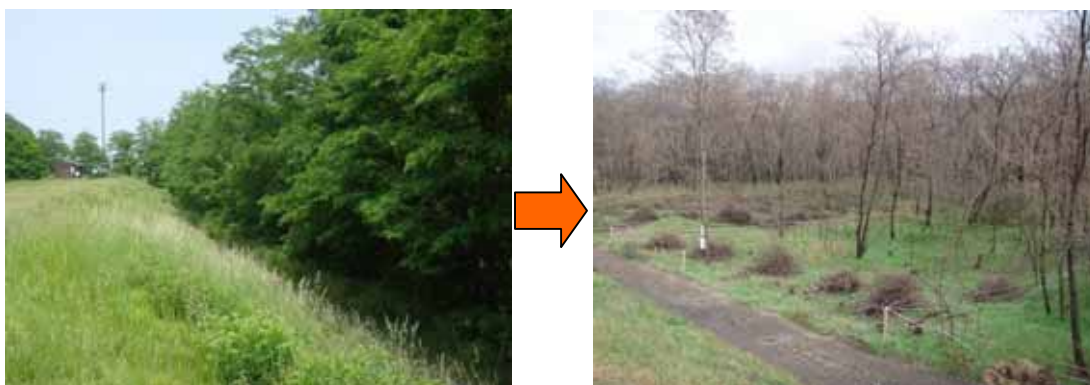
写真 11-10 坂城町坂城地区の樹木伐開状況
