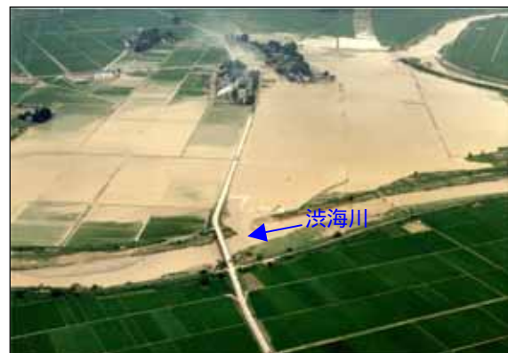
写真 4-24 渋海川破堤状況
