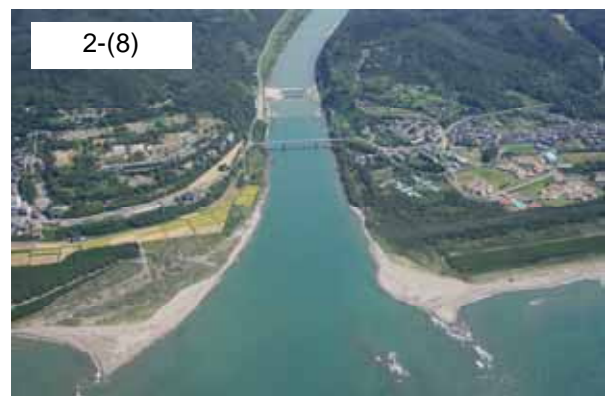
大河津分水路河口【H18 撮影】
