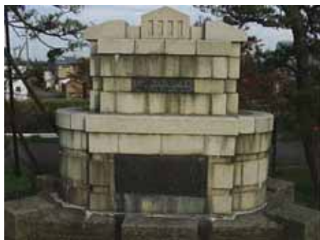
信濃川補修工事竣工記念碑
