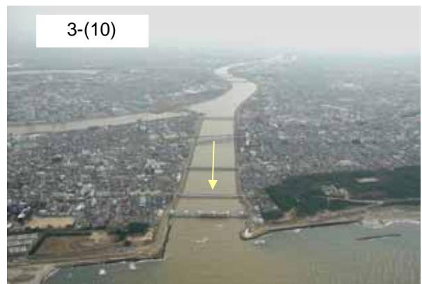
関屋分水路河口
