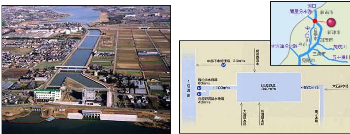
写真 4-91 鳥屋野潟排水機場
