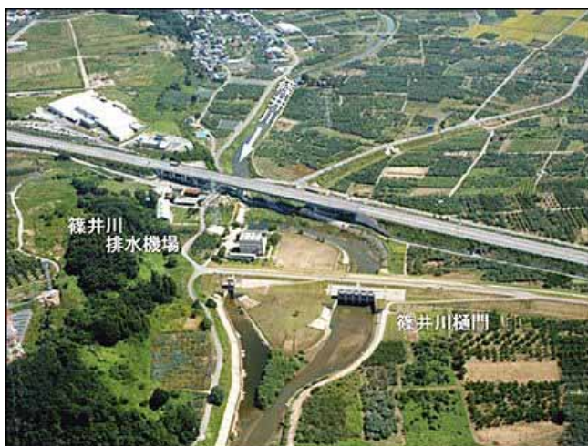
写真 11-9 篠井川排水機場
