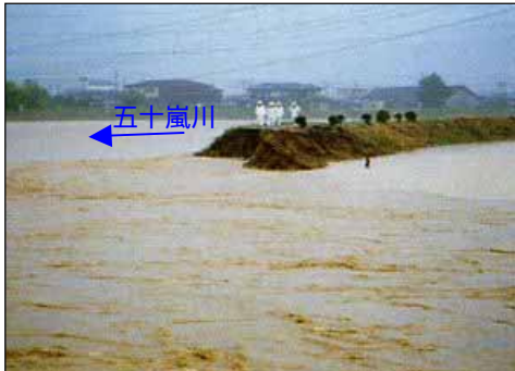
写真 4-42 五十嵐川の破堤状況
