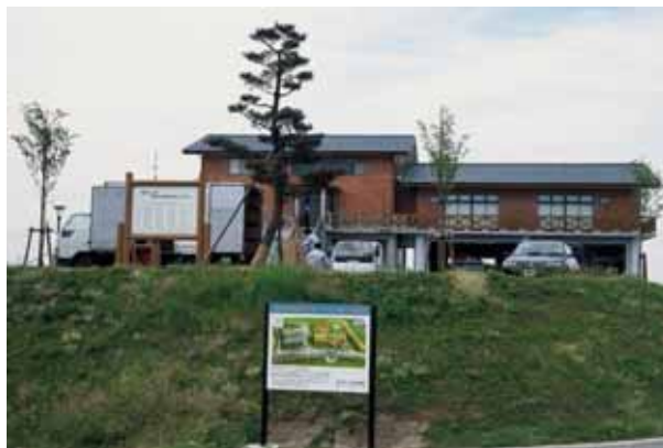
写真 11-13 赤渋河川防災ステーション
