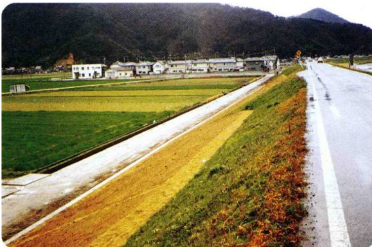
国富地区築堤工事後
