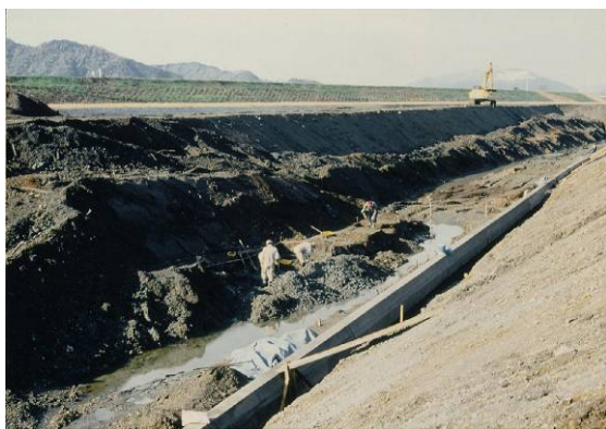
河床遺跡調査の状況
