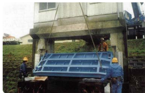
水門・樋門の点検
