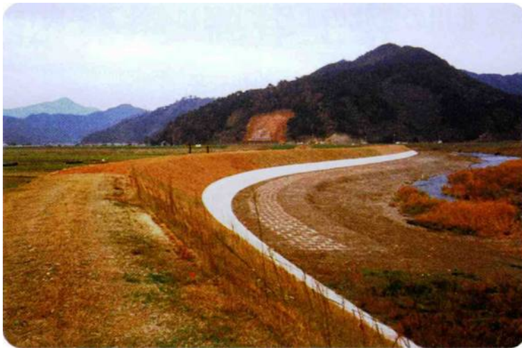
遠敷川左岸築堤・護岸工事後
