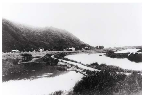
改修工事前の亀の甲付近
