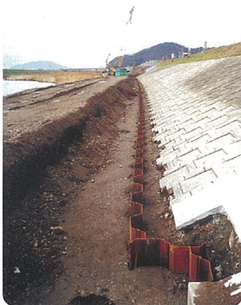
漏水対策工事実施状況
