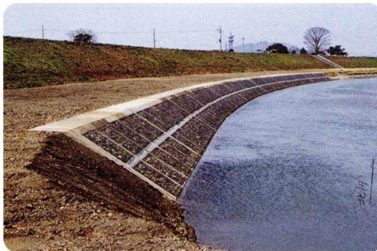
府中地区護岸工事後
