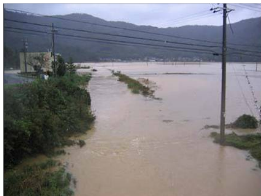
小浜市太良庄地区の浸水状況
