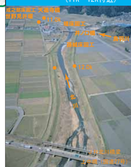
④ 北川・JR北川橋梁付近 (11k~12k付近)
