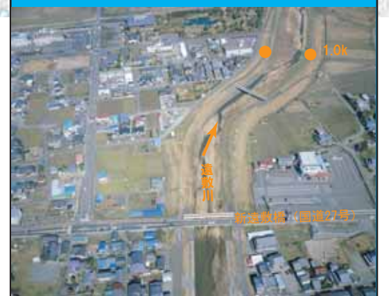
⑥ 遠敷川・新遠敷橋付近 (1k付近)
