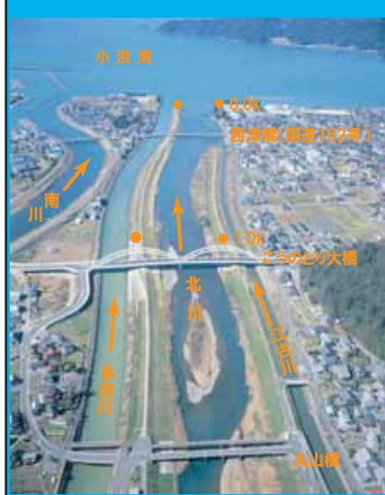
① 北川・河口付近 (0k~1k付近)
