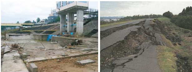
小千谷市千谷川 低水護岸破損
