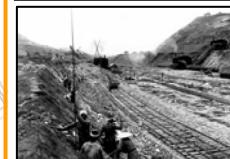
開削工事の状況
