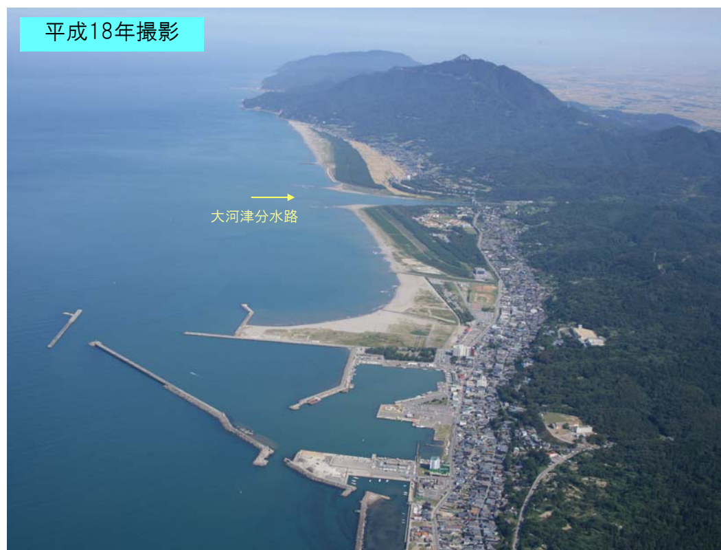
図 5-2 現在の大河津分水路河口の状況
