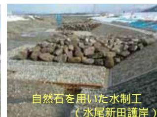
自然石を用いた水制工 (水尾新田護岸)
