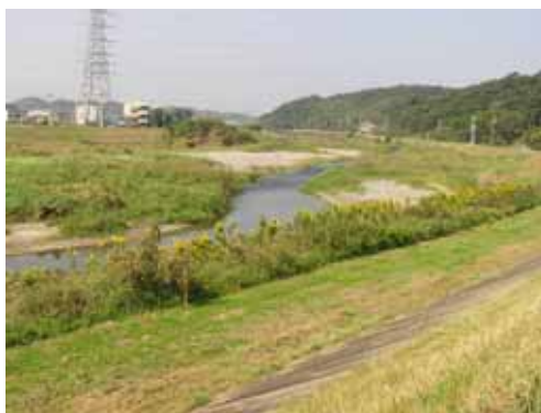
砂礫河原（内部川 3.6k 付近）
