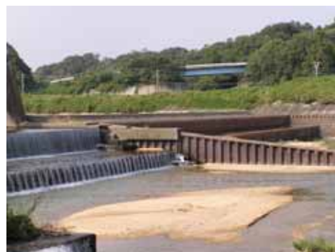
鈴鹿川第二頭首工魚道の状況
