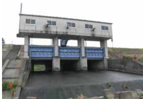
管内排水樋門
