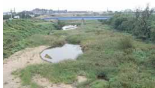
近鉄名古屋線派川橋梁
