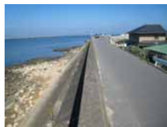
鈴鹿川右岸0.4kの高潮堤防 2
