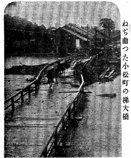
流出直前の梯大橋
