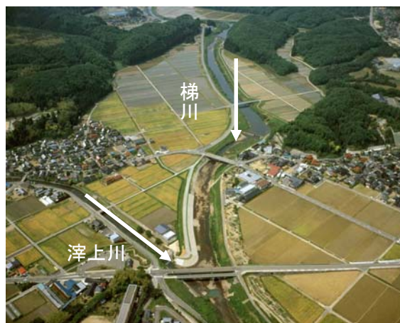
滓上川合流部(河口より 10.7km) 付近
