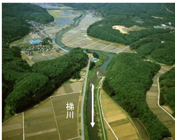
御茶用水頭首工(河口より 12.2km) 付近
