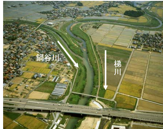
鍋谷川合流部(河口より 7.5km) 付近
