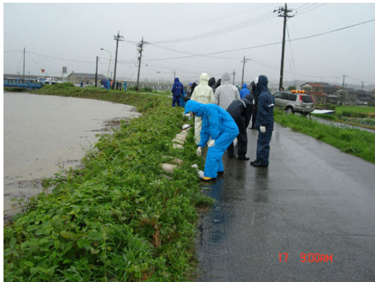
能美大橋左岸下流水防活動
