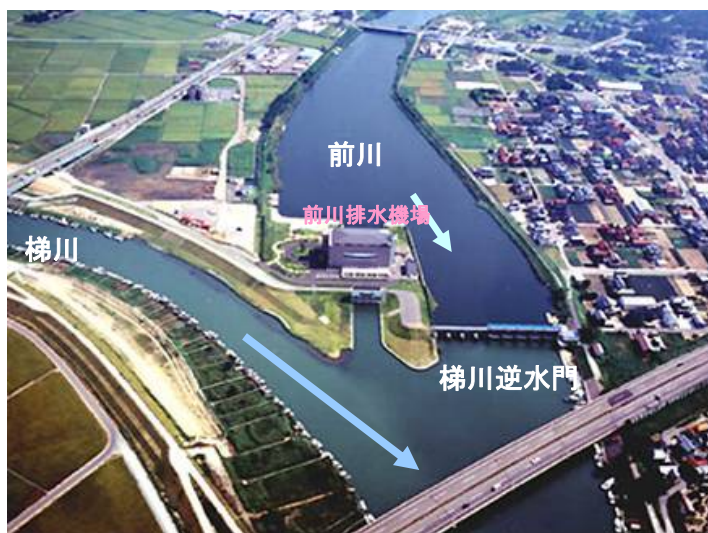
前川排水機場
