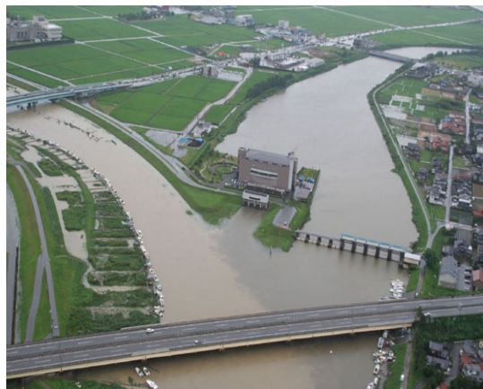
前川排水機場
