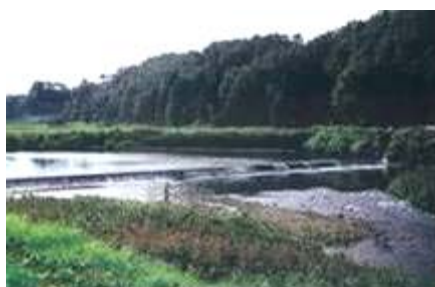
軽海用水頭首工
