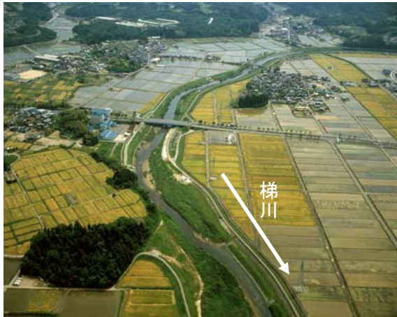
荒木田大橋(河口より 9.2km) 付近
