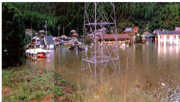
図 4-10 平成 6 年 9 月洪水の相野谷川氾濫状況（紀宝町）
