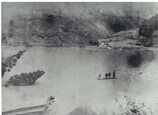
大字林山崩れ、十津川を閉塞
