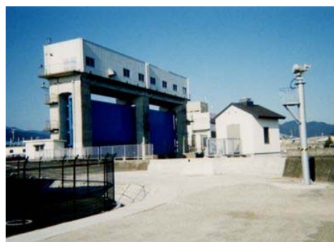
水門等の点検実施
