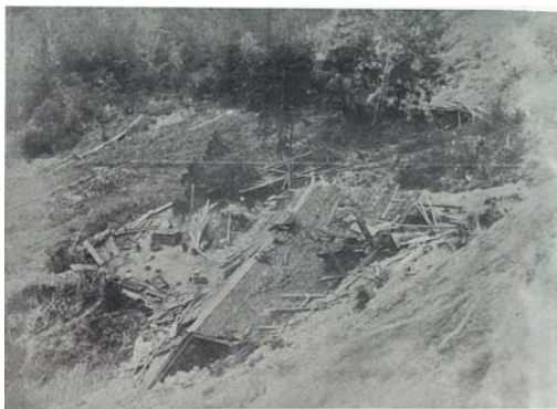
大字小森の山崩れ、家屋崩壊
