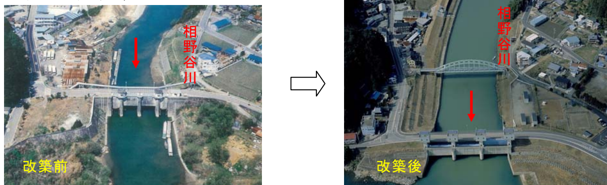
図 4-20 鮎田水門改築事業状況
