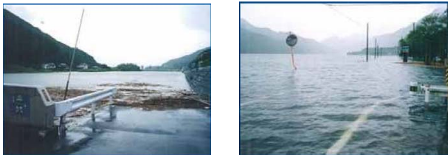
図 4-13 平成 15 年 8 月洪水の相野谷川氾濫状況（紀宝町）
