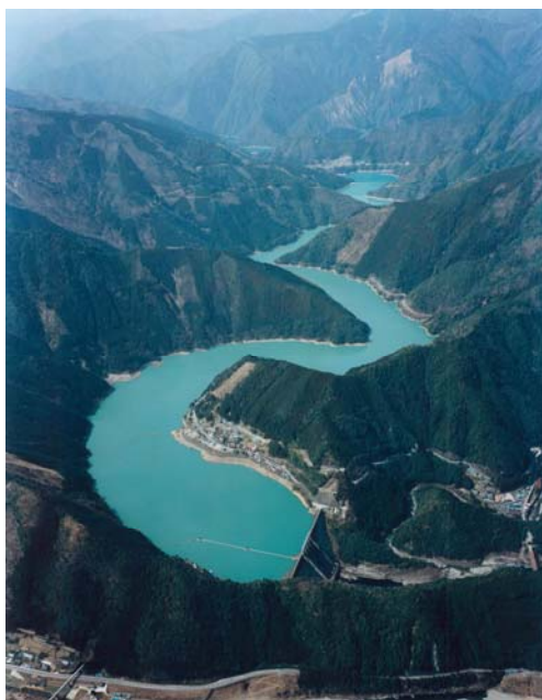
風屋ダム付近（奈良県十津川村）
