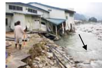
上流部被災状況 (高山市清見町藤瀬)
