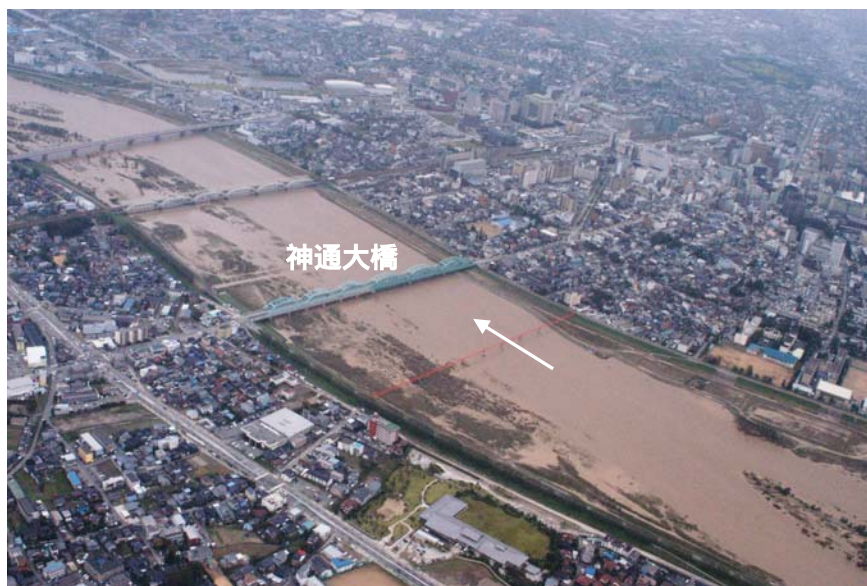
図 4-3 平成16年10月洪水の状況
