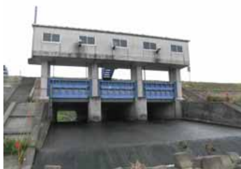
管内排水樋門
