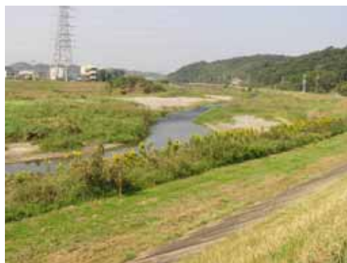
砂礫河原（内部川 3.6k 付近）
