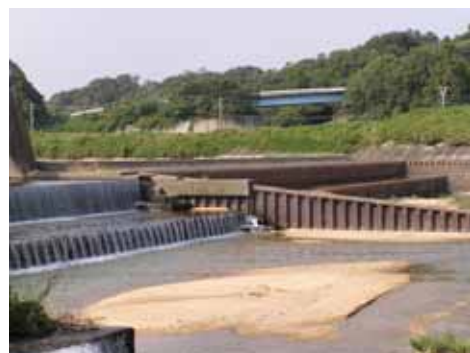
鈴鹿川第二頭首工魚道の状況
