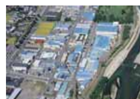
天竜川沿いの工場
