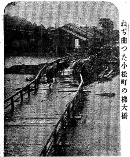
流出直前の梯大橋
