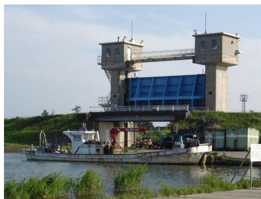
安宅漁港水門
