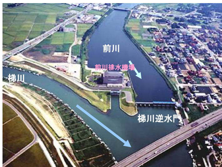
前川排水機場
