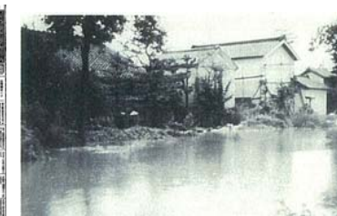
八丁川長野田 大橋下流浸水 状況
