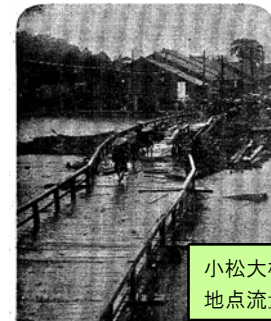
ねち曲がった 小松町の梯大橋
