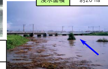
JR梯川鉄橋付近の状況
