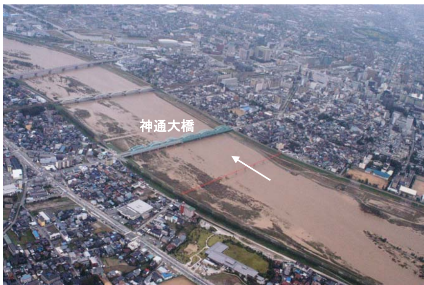
図 4-3 平成16年10月洪水の状況
