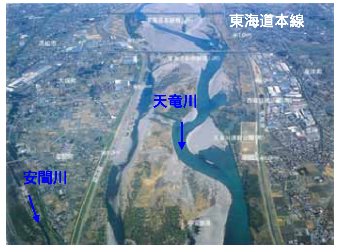
東海道線下流部付近の状況
