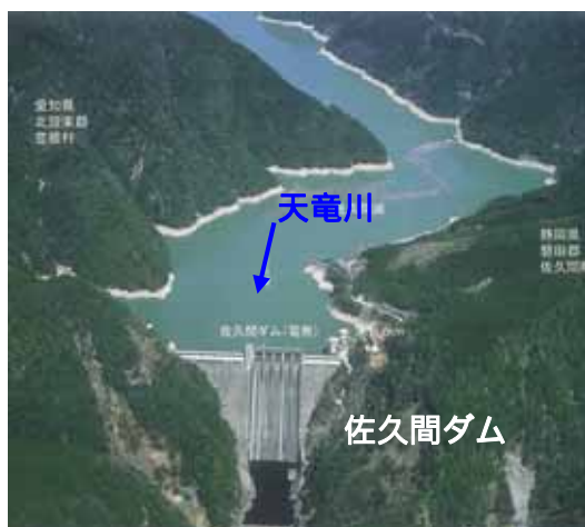
佐久間ダム付近の状況
