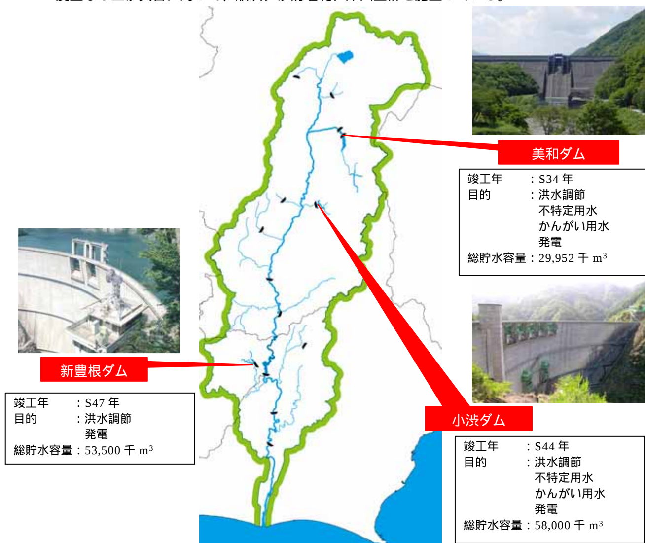
図 4-6 工事実施基本計画における主要な河川工作物
