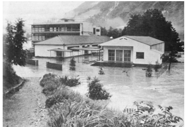
浜松市佐久間小学校の浸水状況
