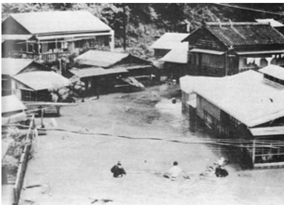
浜松市佐久間地区の浸水状況
