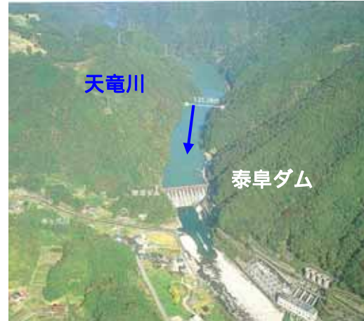
泰阜ダム付近の状況
