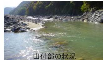
山付部の状況
