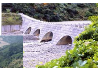
浦川スーパー暗渠砂防堰堤(H8年着手/H10年完成)
