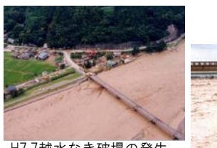
H7.7越水なき破堤の発生
