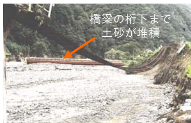
JR平岩駅北側の線路は、200mにわたって路盤が流出
