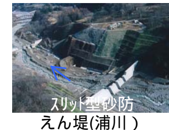
スリット型砂防えん堤(浦川)
