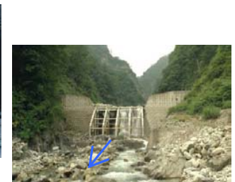
鋼製砂防えん堤(松川)
