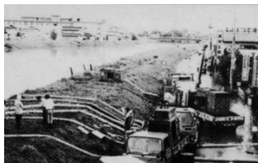
内川（鶴岡市鳥居町地内：内水排除の様子）
