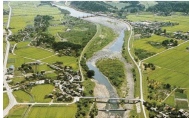
平成元年 7 月 赤川頭首工下流
