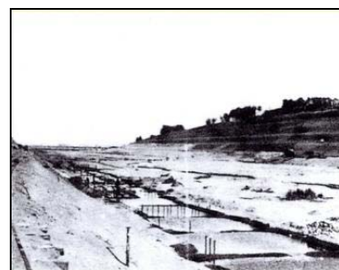
放水路開削工事の様子 (昭和8年)
