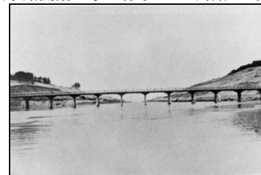
赤川放水路一部通水後 (昭和3年撮影)
