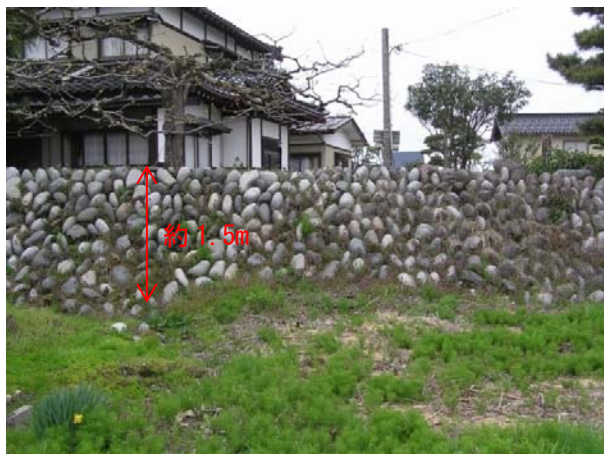
熊出付近の石積み自衛堤
