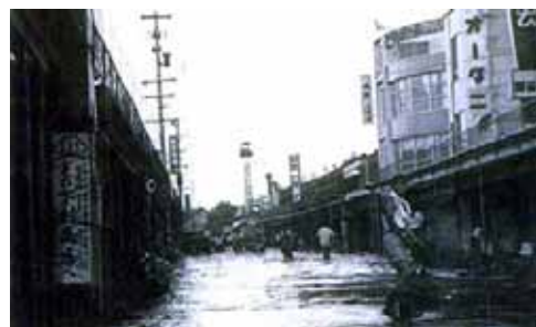
西脇市内の浸水状況
