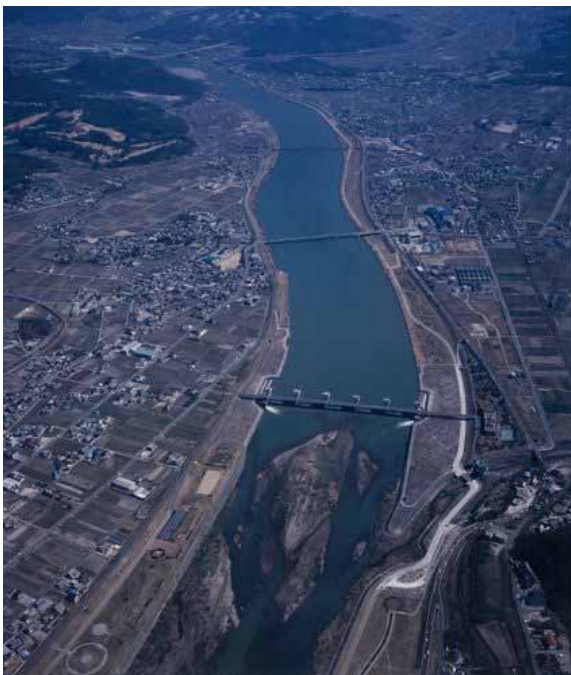
加古川大堰湛水区間
