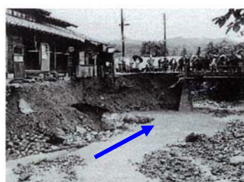
上本郷地区の災害状況 (昭和46年発生)
