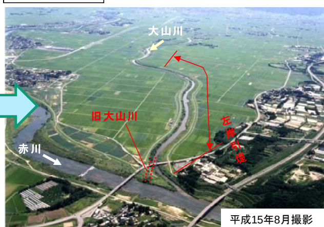
大山川改修後
