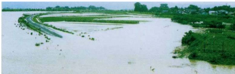
赤川（三川町横山地区：蛾眉橋）
