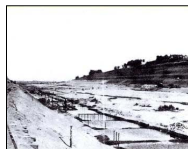
放水路開削工事の様子（昭和 8 年）
