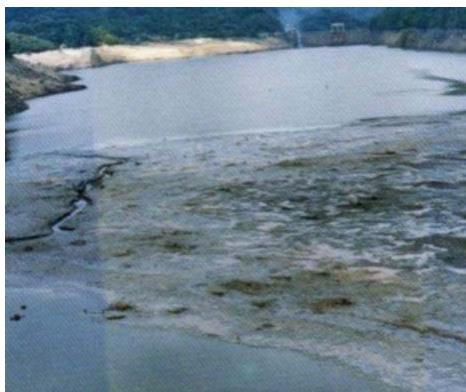
昭和 60 年 8 月 荒沢ダムの様子
