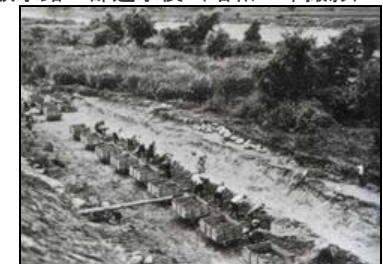
土砂運搬作業の様子(昭和 8 年)
