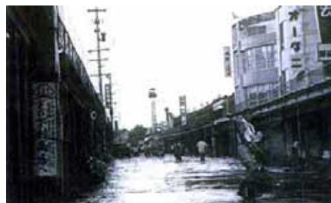
西脇市内の浸水状況
