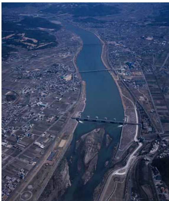
▲ 加古川大堰湛水区間
