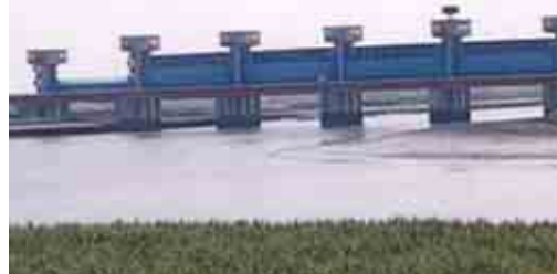
写真4-10 六角川河口堰
