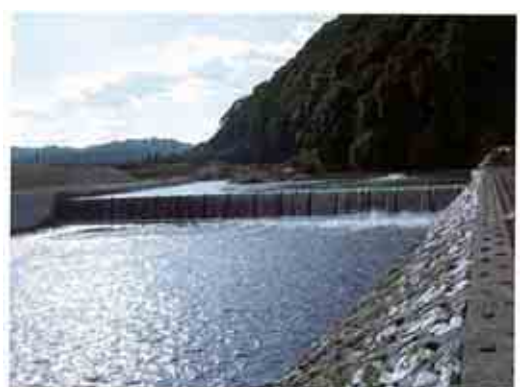
写真 4-15(3) 大井手堰(平成 17 年 1 月完成)
