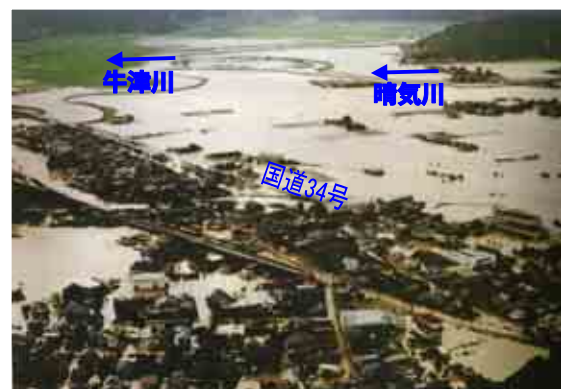
写真 4-5(2) 小城市牛津町浸水状況 (旧牛津町中心街)
