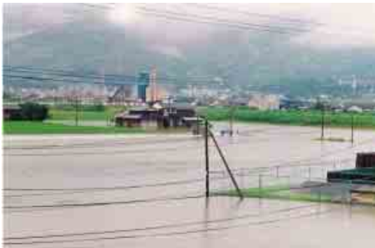
写真 4-6 多久市の浸水状況(H5.8)
