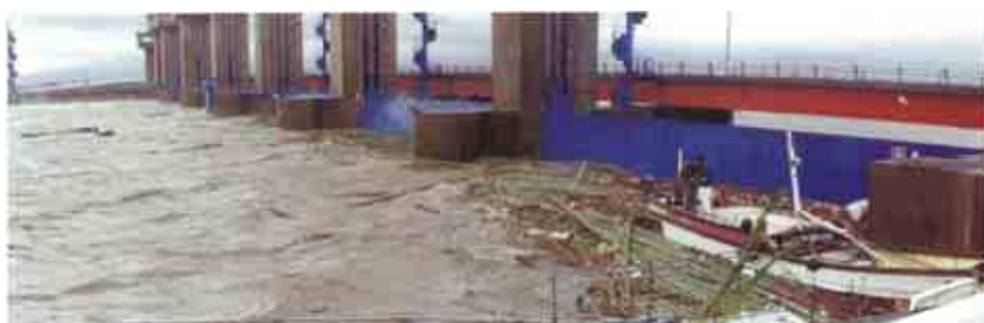
写真4-11 昭和60年台風13号での高潮防御状況
