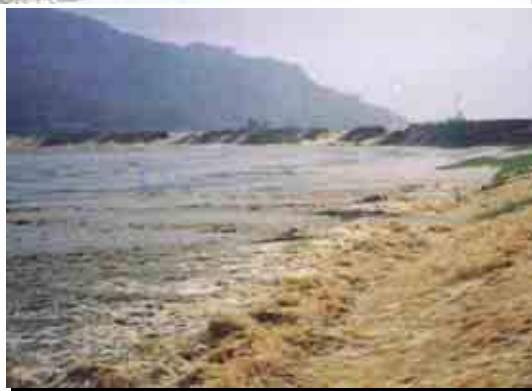
④ 牛津川納所地区越水状況
