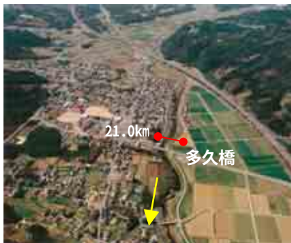
牛津川上流部：多久橋(20.8km)付近
