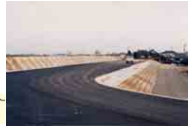
写真 4-14 高潮堤防の築造
