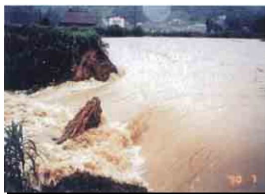
② 破堤氾濫状況（武雄市大日地区）
