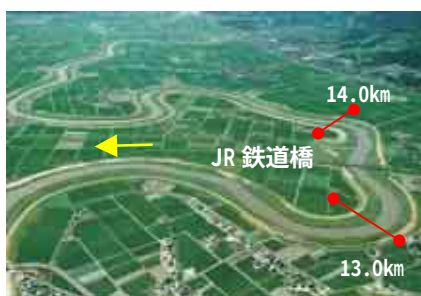
下流部：JR 鉄道橋(13.5km)付近
