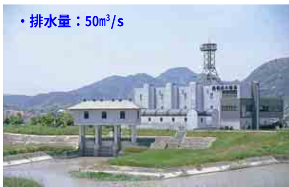
写真 4-13 高橋排水機場(平成 9 年 3 月完成)
