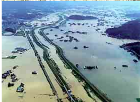
③ 六角川下流地区浸水状況（武雄市志久・芦原地区）
