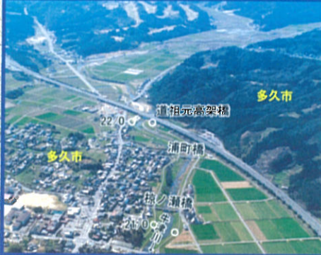
⑧浦町橋地点 [21.4 k 付近]
