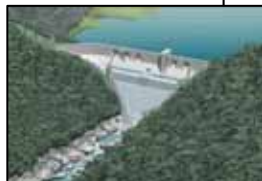
横瀬川ダム(建設中)
