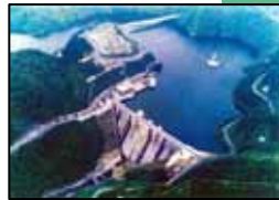
中筋川ダム(平成10年完成)
