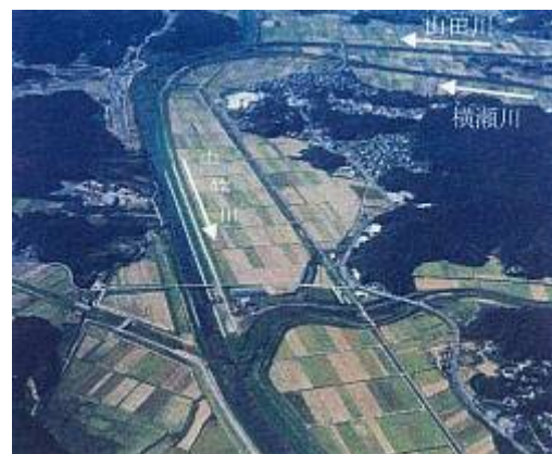
中筋川 15k 付近
