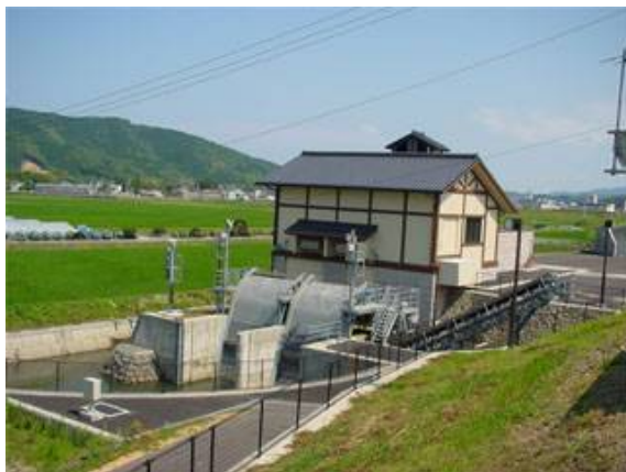
かわいそがわ 川家川排水機場
