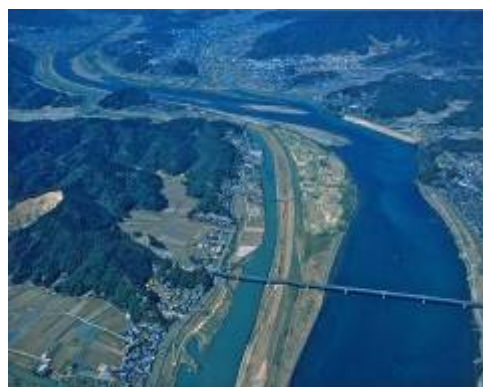
山路橋付近下流部(上流方向を望む)
