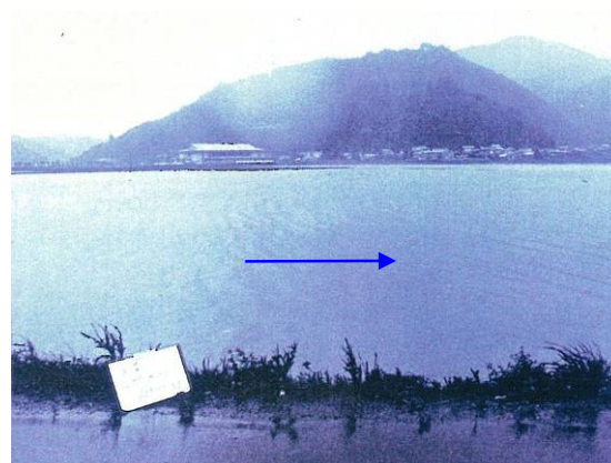
安並地区（堤内側）付近の状況
