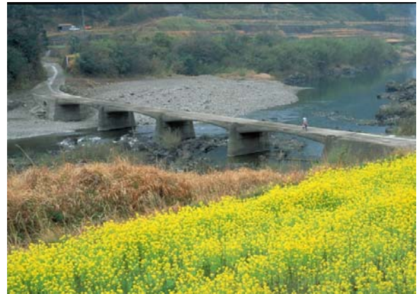
上岡沈下橋（100k 付近）
