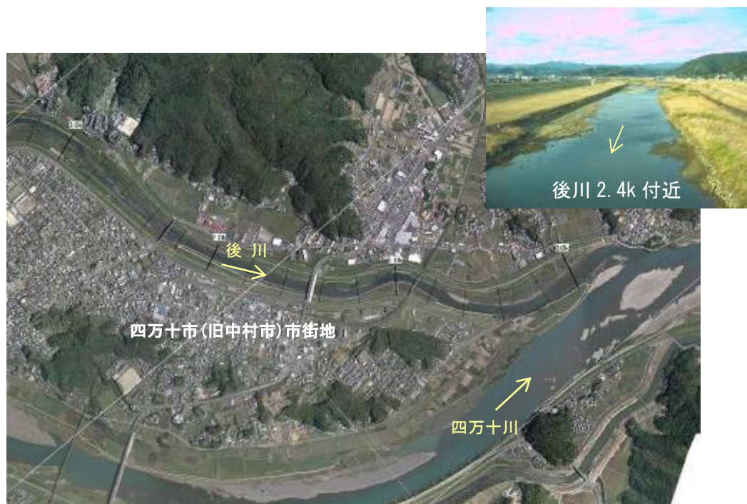
後川合流点付近
