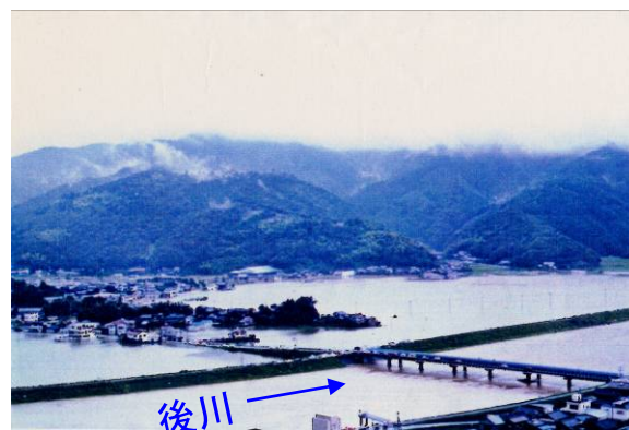
後川橋付近の状況
