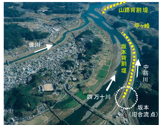
中筋川の改修
