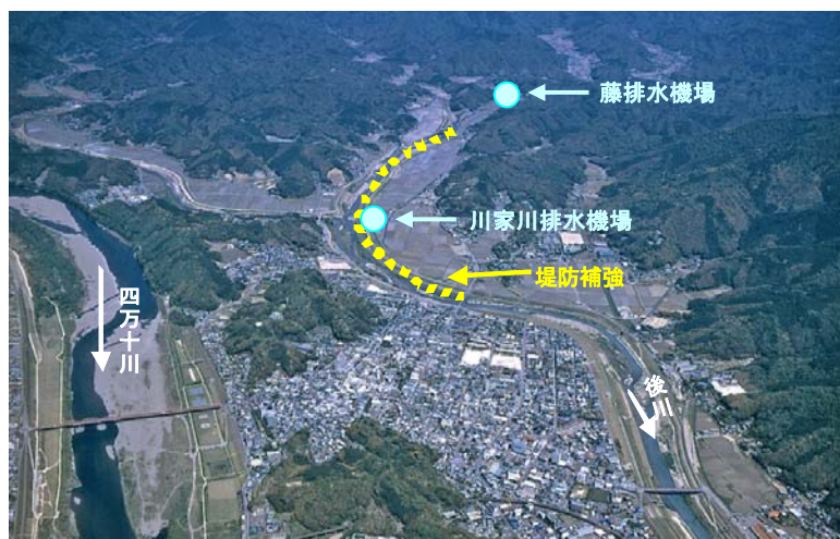
後川床上浸水対策特別緊急事業
