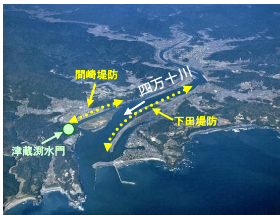
下田堤防・間崎堤防
