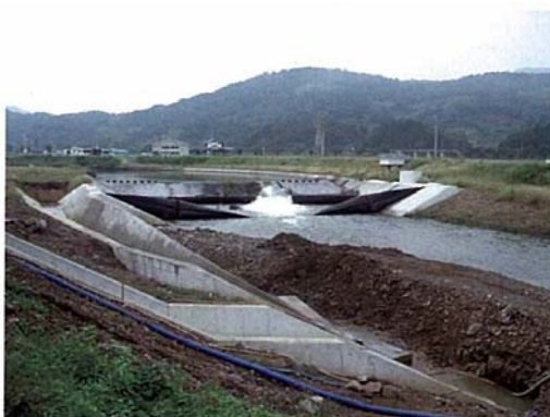
写真 4-15(2) 小井手堰（平成17年3月完成）
