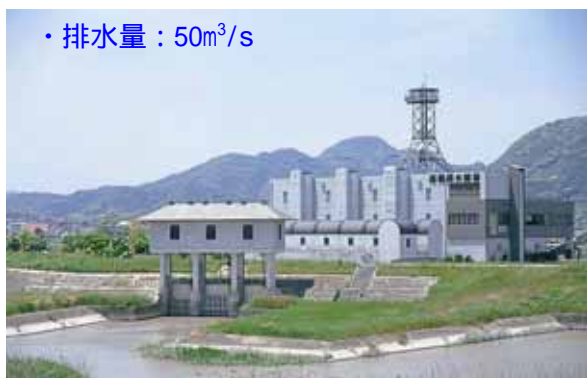
写真 4-13 高橋排水機場(平成9年3月完成)
