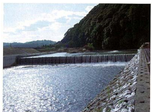
写真 4-15(3) 大井手堰（平成17年1月完成）
