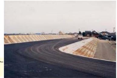
写真 4-14 高潮堤防の整備
