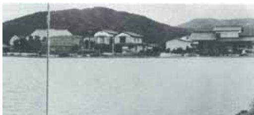
写真 4-4 杵島郡江北町の内水氾濫状況 (惣領分・馬場地先)
