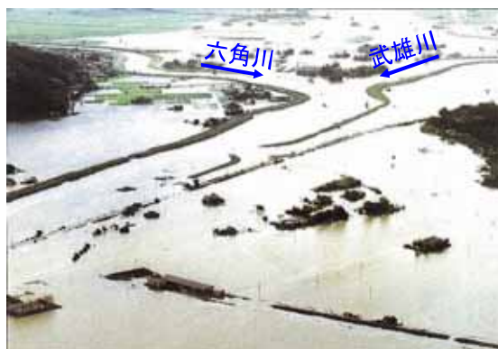
写真4-5(1) 武雄市浸水状況 (六角川と武雄川合流点周辺)
