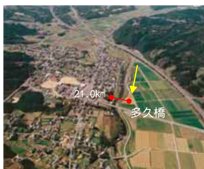
牛津川上流部：多久橋(20.8km)付近
