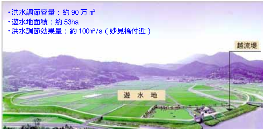
写真4-12 牟田辺遊水地（平成14年6月完成）
