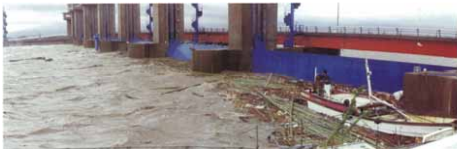
写真4-11 昭和60年台風13号での高潮防御状況
