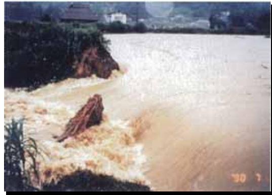
破堤氾濫状況(武雄市橘町永島地区)
