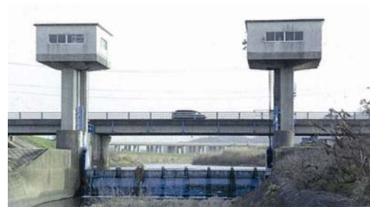
写真 4-15(1) 大日井堰（昭和57年3月完成）
