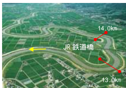
六角川下流部：JR 鉄道橋(13.5km)付近
