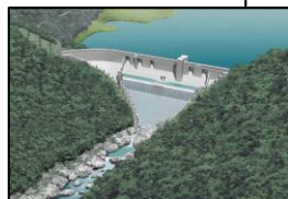
横瀬川ダム(建設中)
