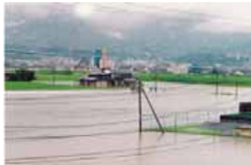
多久市の浸水状況
