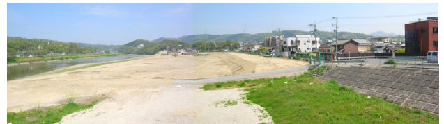
施工後(平成20年撮影)
