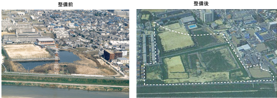
写真4.19 スーパー堤防整備実施箇所
