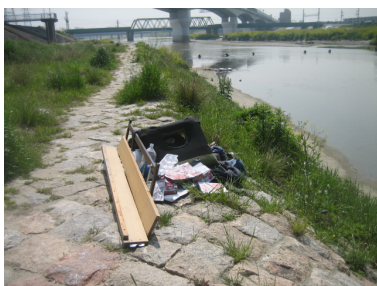
写真 9.1 国道 26 号大和川大橋付近（右岸）
