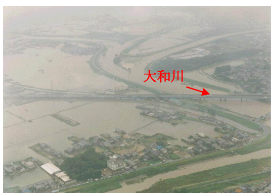
写真 4.10 安堵町・河合町付近
