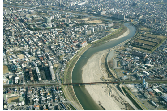
施工後(平成19年撮影)
