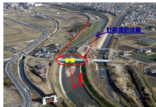
施工後(平成20年撮影)
