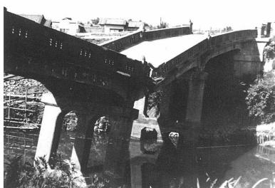
写真 4.6 大和郡山市板東付近
