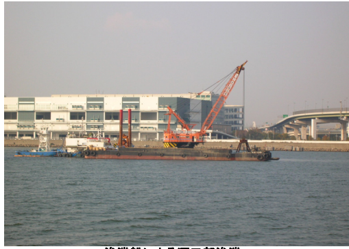
浚渫船による河口部浚渫
