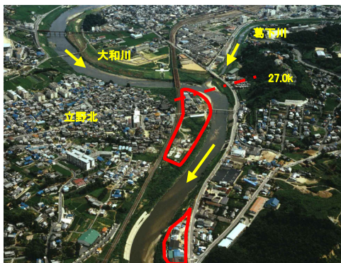
施工前(昭和58年8月撮影)
