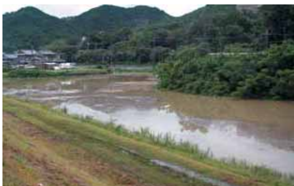
赤磐市熊山地区の内水による浸水
