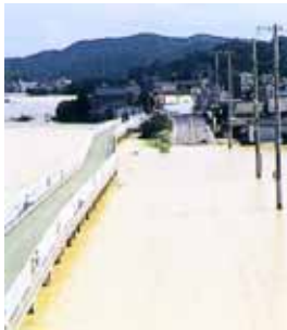
瀬戸内市邑久町の浸水状況
