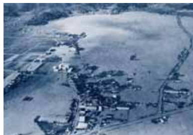
瀬戸内市長船町の浸水状況
