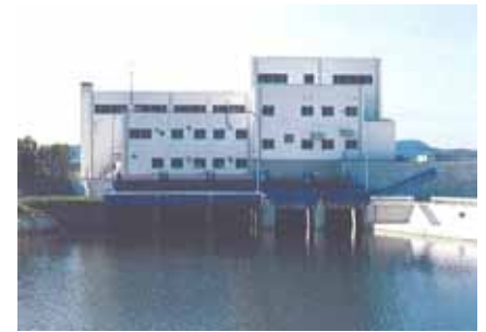
千田川排水機場
