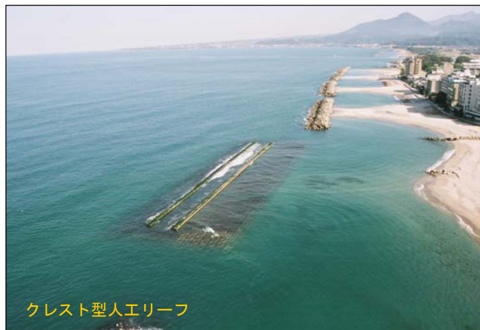
図 8.4 反射波抑制のための海岸保全施設の整備
