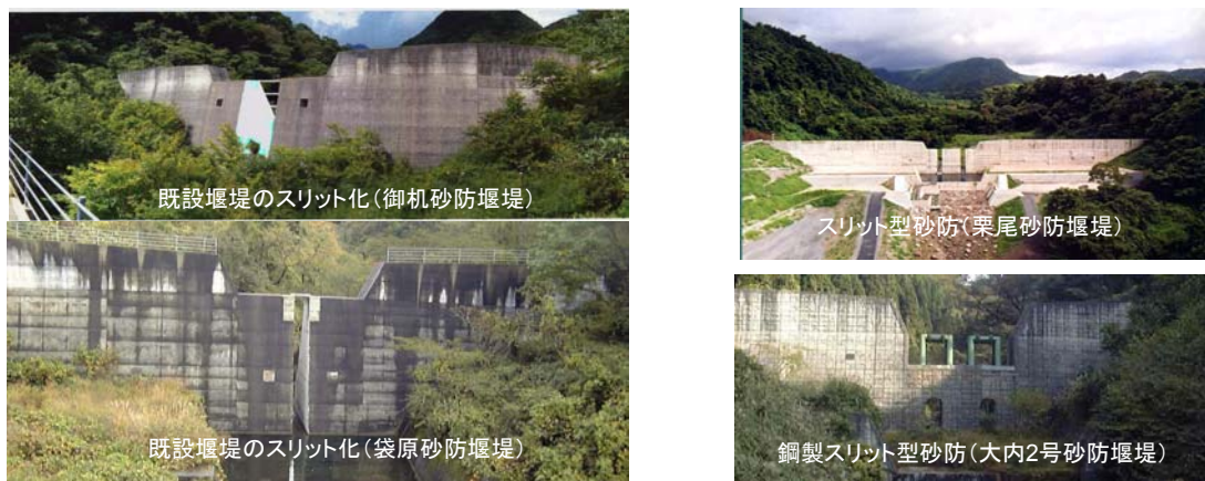
図 3.3 砂防堰堤の整備状況
