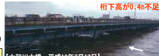
【大和川大橋 平成19年7月17日】
