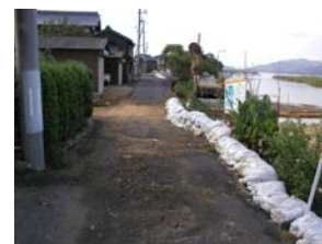
H16台風16号被災状況
