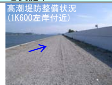
高潮堤防整備状況(1K600左岸付近)
