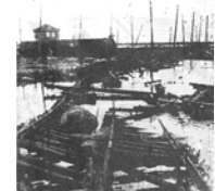
阪堺線(大和川付近)
