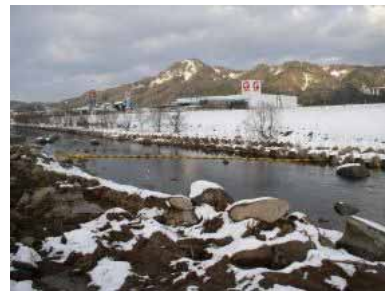
オイルフェンス設置後
