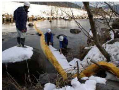
オイルフェンス設置状況
