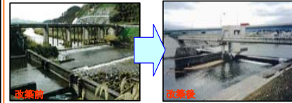
(法勝寺川堰の改築事例)
