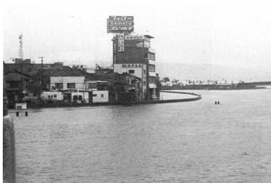
昭和 47 年 7 月出水 央道湖の水位上昇の状況 (松江市魚町)
