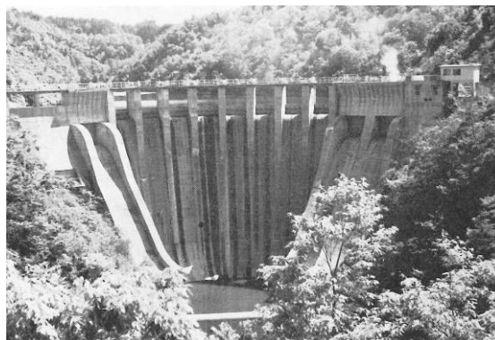
三成アーチダム(貯水ダムとして S28 完成)
