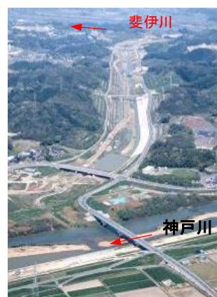
斐伊川放水路開削部の状況
