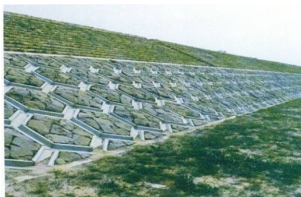
裏石張工（中詰石を使用している亀甲張り）
