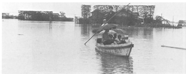
昭和 47 年 7 月出水 斐川町郊外の浸水・非難状況
