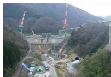
志津見ダム(本体工事状況)
