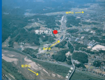
⑭斐伊川放水路 斐伊川からの分流水
