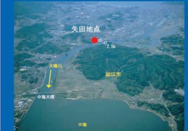
④ 大橋川 中海大橋付近
