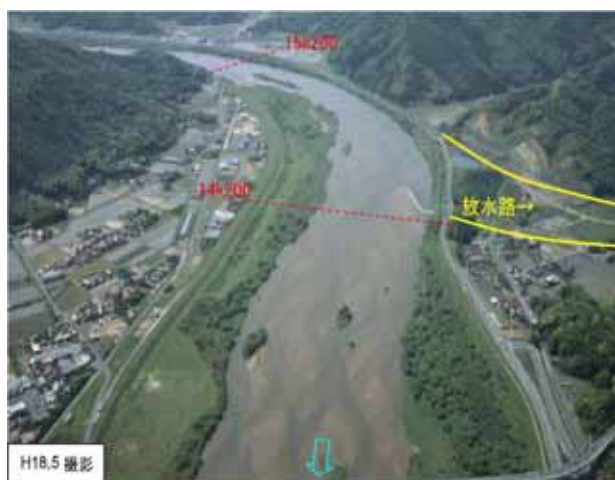
図 5.1.1 斐伊川本川分流部付近の状況
