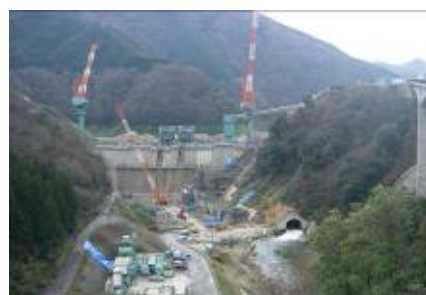
志津見ダム(本体工事状況)
