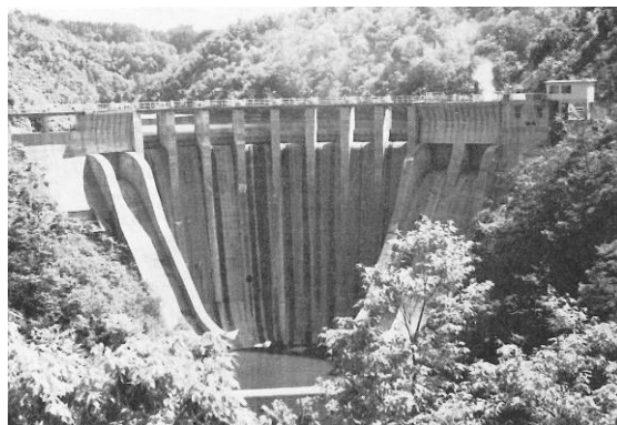
三成アーチダム(貯水ダムとして S28 完成)
