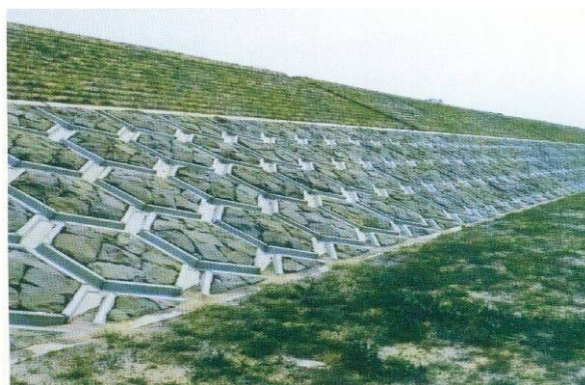
裏石張工（中詰石を使用している亀甲張り）
