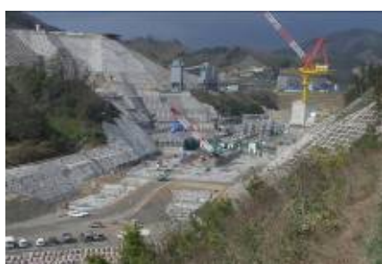
尾原ダム(本体工事状況)
