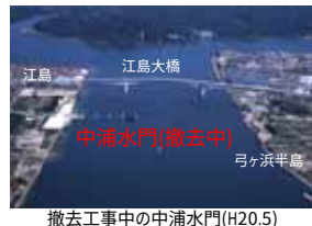
撤去工事の中浦水門(H20.5)
