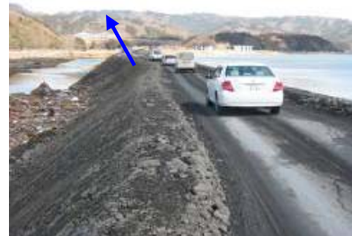
堤防嵩上げ状況 (第1ステップ)
