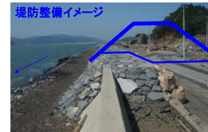
堤防嵩上げ (第3ステップ)
