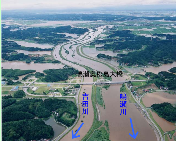
広い範囲で浸水被害が発生
