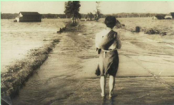
鳴瀬川三本木：奥州街道沿いの橋梁が水没
