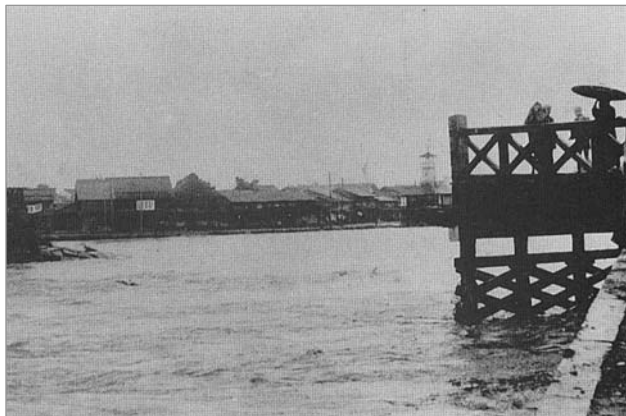
写真 明治 43 年洪水の被害状況
