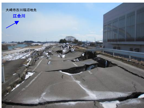
江合川右岸 26.6k 付近 (大崎市古川福沼地先) ※地震により縦断クラック発生
