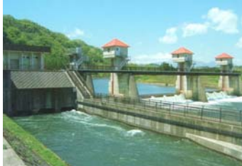
● 鹿妻頭首工（雫石川）
