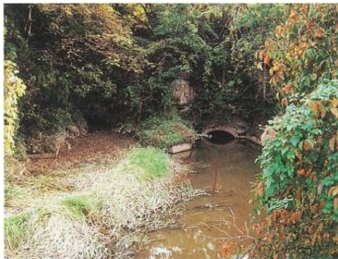
元禄潜穴（北上川下流河川事務所）
