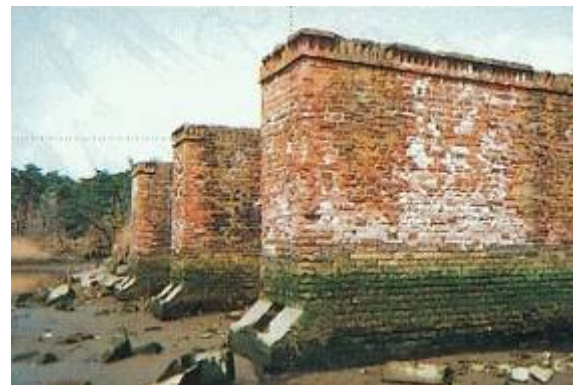
野蒜築港計画で建設された橋脚
