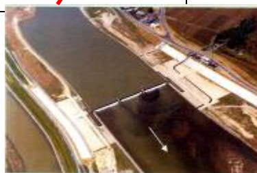
鳴瀬堰(H2 完成)
